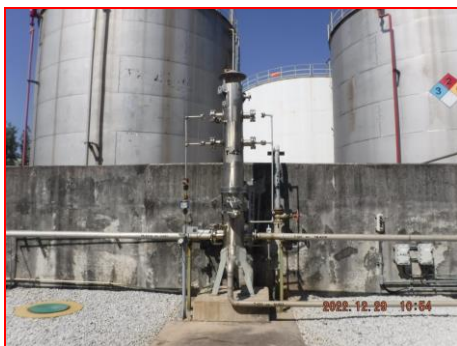
ภาพที่ 2.2-5 Seal Pot บริเวณถังเก็บกรดอะซิติก
