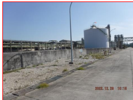
ภาพที่ 2.2-54 กำแพงกันสารเคมี เพื่อป้องกันสารเคมีหกั่วไหล
