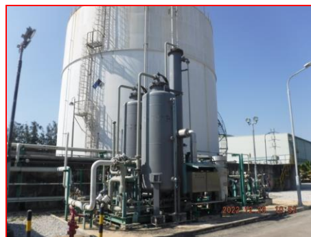
ภาพที่ 2.2-6 หอดูดซับสารอินทรีย์ระเหยง่าย (VRU)
