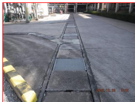
ภาพที่ 2.2-23 รางระบายน้ำฝนภายในโรงงาน
