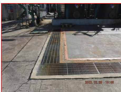
ภาพที่ 2.2-26 รางระบายน้ำฝนปนเปื้อนภายในโรงงาน
