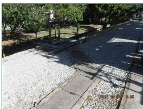
ภาพที่ 2.2-24 รางระบายน้ำฝนที่เชื่อมต่อกับรางระบายน้ำฝนของนิคมฯ
