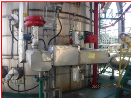
ภาพที่ 2.2-53 Shut Down Valve และ Safety Valve
