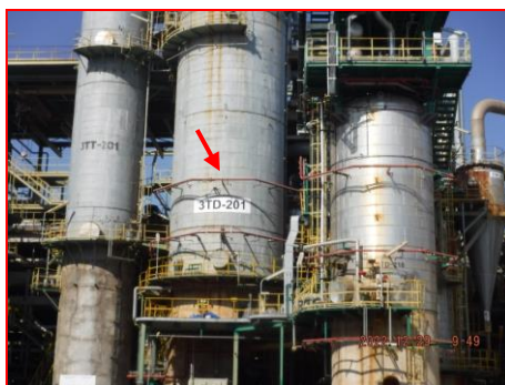
ระบบสเปรย์น้ำ (Spray) ของโรงผลิตที่ 3 ภาพที่ 2.2-44 ระบบสเปรย์น้ำ (Spray) (ต่อ)
